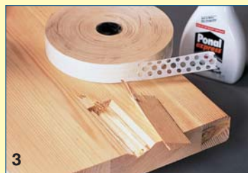
3 Για να κολλήσετε ένα απόφιο σπασμένου κομμάτι, εφαρμόζετε την ίδια μέθοδο. Δοκιμάστε πρώτα την εφαρμογή του στερεώνοντάς το πρόχειρα.
