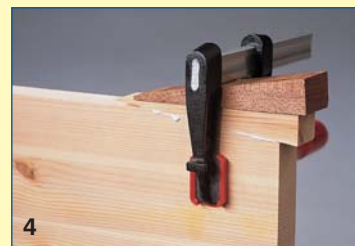
4 Συμπληρώστε μια σπασμένη γωνία σανίδας με μια σφήνα με την ίδια κατεύθυνση ινών. Πιέστε την κάτω από το σφιγκτήρα με μια δεύτερη σφήνα.
